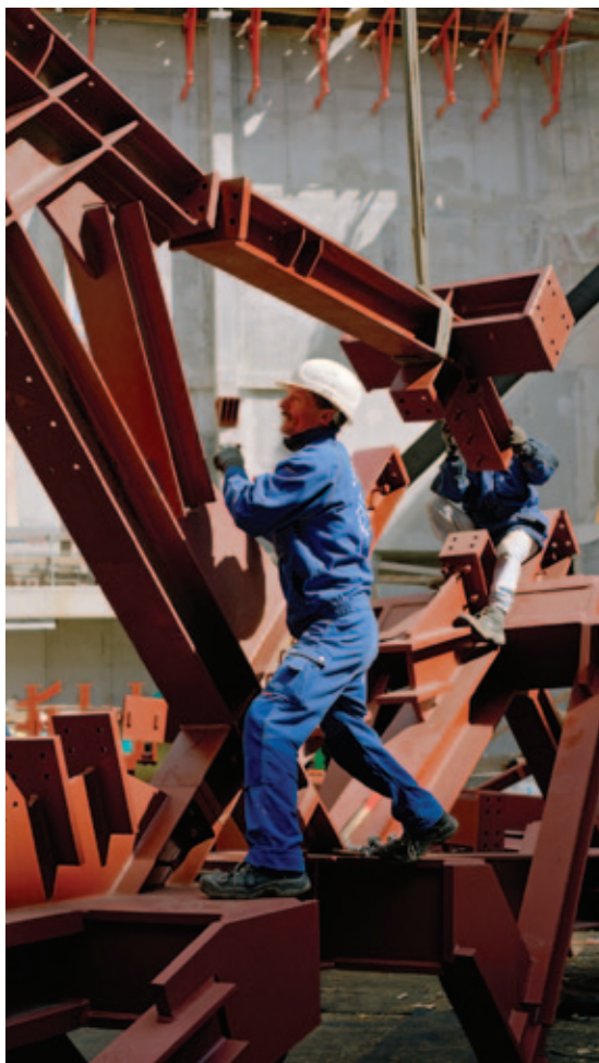
Forrás: HASLINGER Acélszerkezetépítő Kft.
