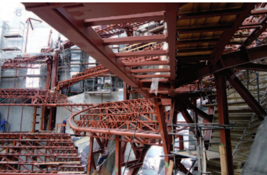
Forrás: HASLINGER Acélszerkezetépítő Kft.
