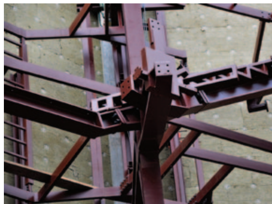
Forrás: HASLINGER Acélszerkezetépítő Kft.
